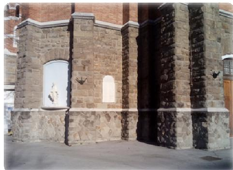
Sostituzione di alcune pietre del muro della chiesa dell'oratorio con successivo rifacimento di tutte le fughe, fino a 1,60 m di altezza.
